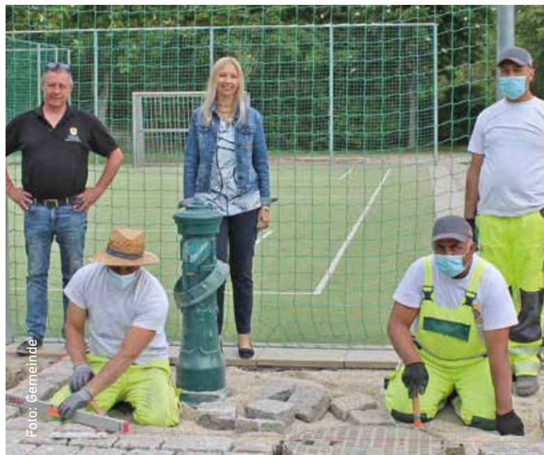
Bürgermeisterin Monika Obereigner-Sivec und der Leiter der Abteilung Wasser, Christian Lamminger sind beim Lokalaugenschein über den schnellen Baufortschritt mehr als zufrieden.
